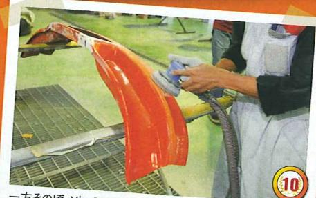
一方その頃、Y's-CUPで破損してしまったケルシャーのフロントスポイラーの修理と塗装の作業も並行して行なわれていた。破損した部分が大きかったので、当初は「えっ、これ直すんですか? 考えさせてください」といわれてしまったものの、古Q編集長の希望もあって無理をお願いすることにしたのだ。
